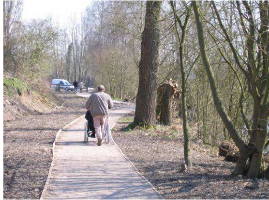
Sentier après les travaux d'aménagement - 2010
