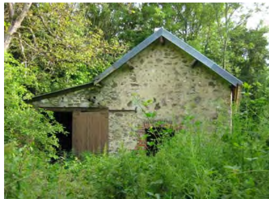
Bâtiment en ruine, parcelle 46
