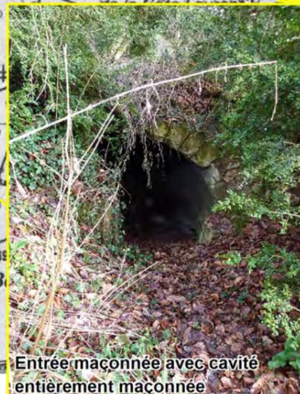
Entrée maçonnée avec cavité entièrement maçonnée
