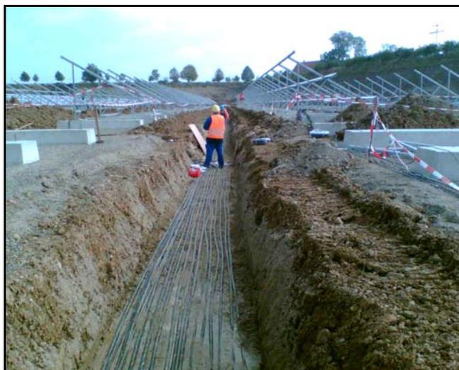
Figure 1 : Exemple de pose des câbles dans une tranchée – Phase chantier à Darrast, Bavière, (photo : M. Mack)
