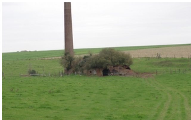
Vestiges d'une briqueterie à St-Christ-Briost (80). Photo Y. Duquef
