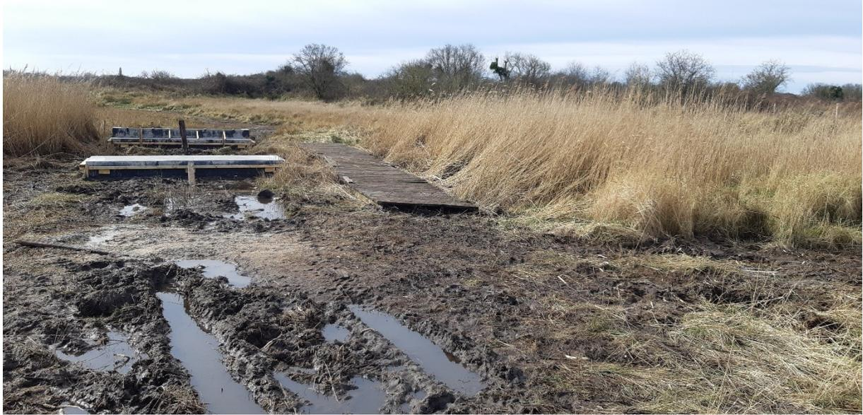
Élargissement du chemin des Mollières pour l'installation de la nouvelle passerelle métallique avec bardage bois et supports en béton (ci-dessous), ceci sans tapis de protection comme prévu
